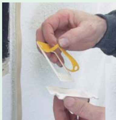
5. Schutzfolie lösen und Zellkautschuk-Dichtrahmen aufkleben
