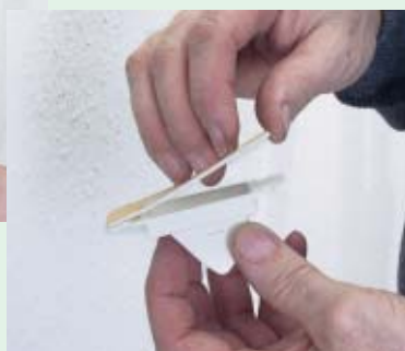
5. Schutzfolie lösen und Zellkautschuk-Dichtrahmen aufkleben
