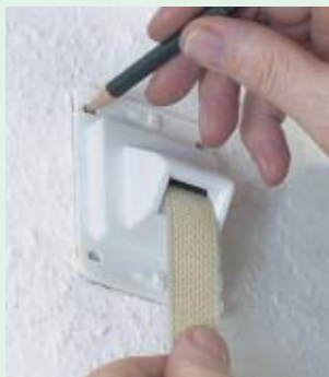
7. Schraubposition anzeichnen
