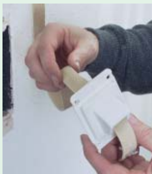
6. Gurtband in ESM-Gurtführung einziehen
