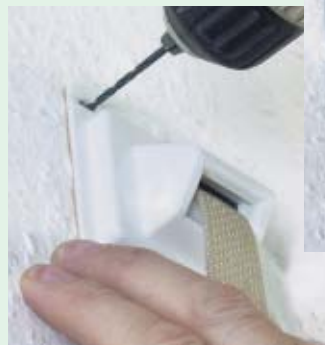
8. Bohren direkt mit der ESM-Gurtführung oder mit der Bohrschablone (verhindert das Verlaufen des Bohrers bei Beton, etc.)
