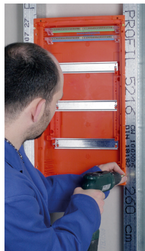
● Hohlwandverteiler können über die vorgestanzen Löcher einfach an die Profilschiene geschraubt werden
