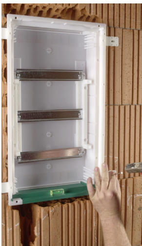
● Leitungseinführungsschieber als Wasserwaage
